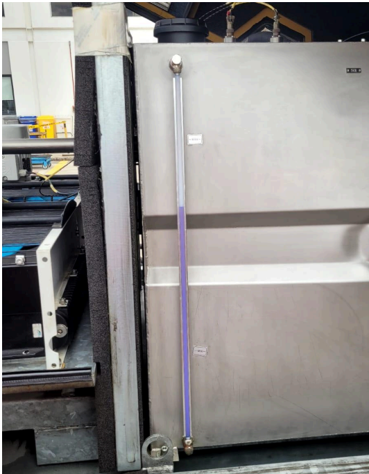
Fotografía 5. Inspección de nivel de aceite en el interior del tanque.
