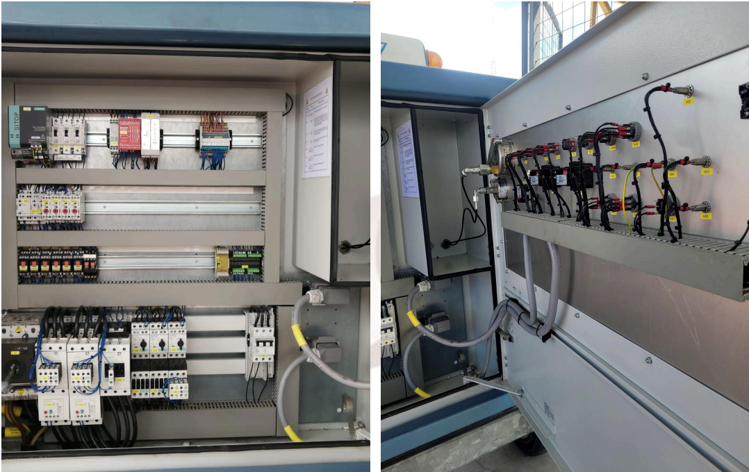
Fotografía 2. Interior del panel de distribución eléctrica y anclaje de tierra.
