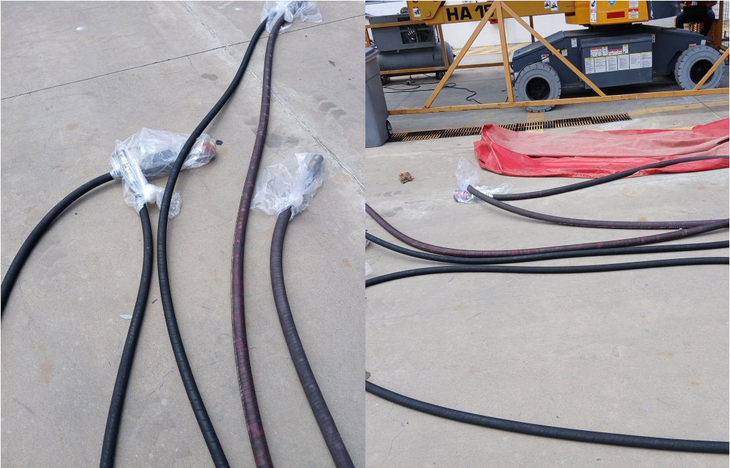
Fotografía 7. Inspección y limpieza de mangueras.
