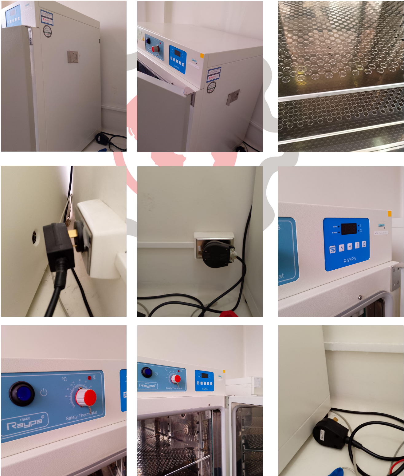
Fig. 1 Mantenimiento preventivo básico
