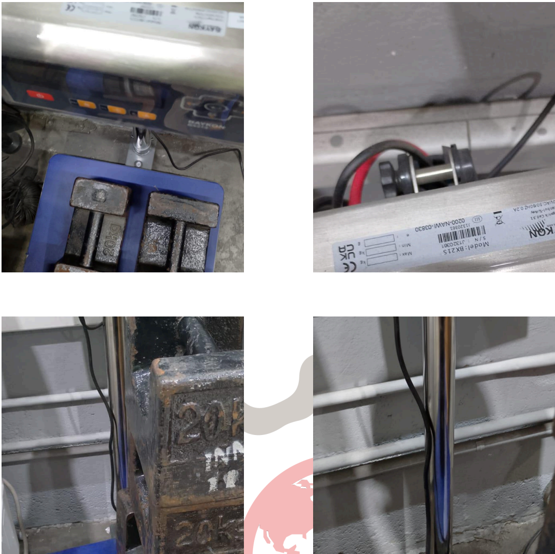
Fig.1 Mantenimiento del Equipo.
