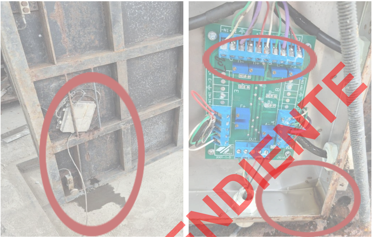
Filtración de agua en la caja de control. Óxido y sulfato en contactos electrónicos.
