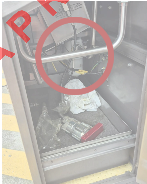
Fotografía 2. Goteo en unión de tuberías.
