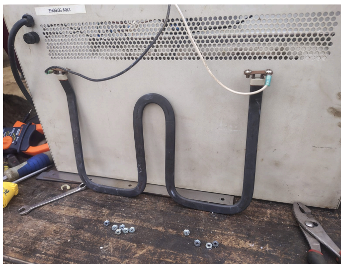
Figura 1. Resistencia Desmontada
