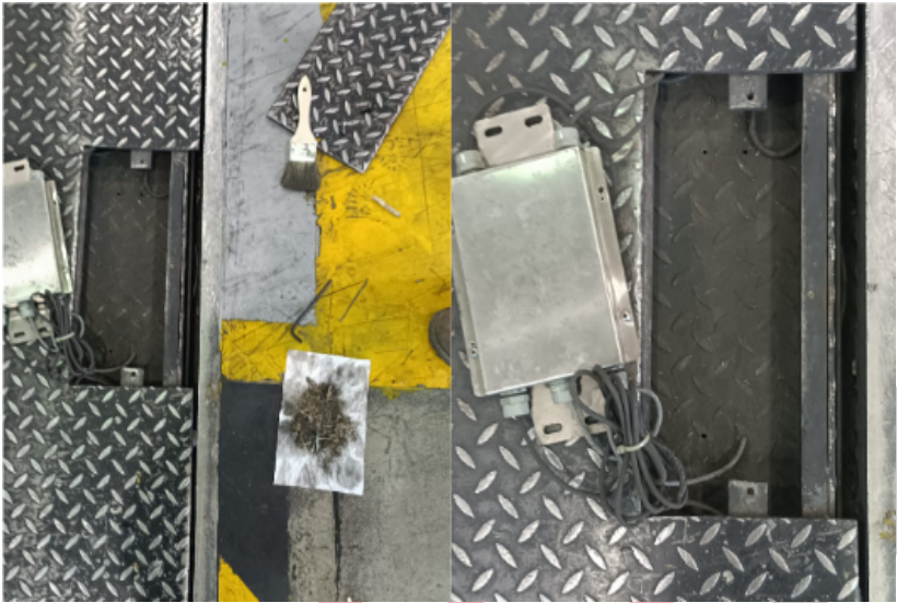
Fig. 1 Mantenimiento del Equipo
