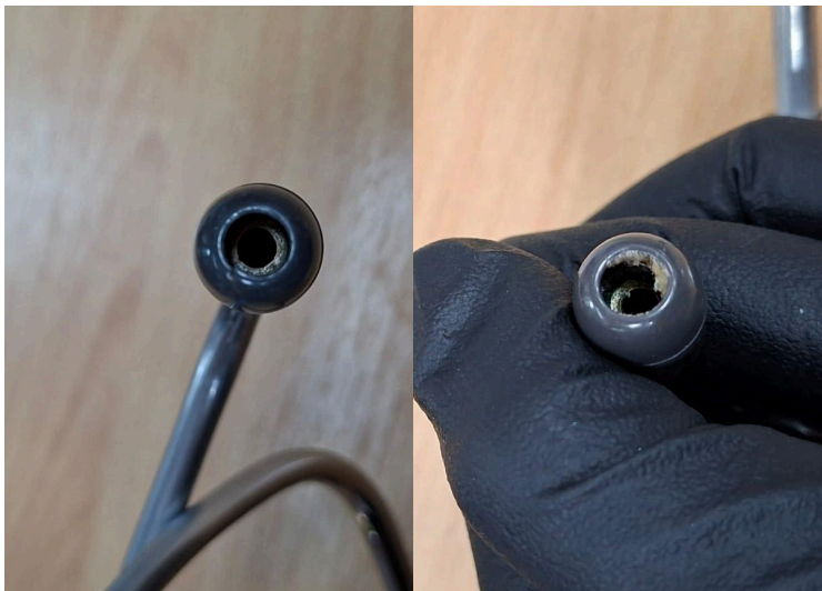
Figura 2. Equipo antes de mantenimiento.
