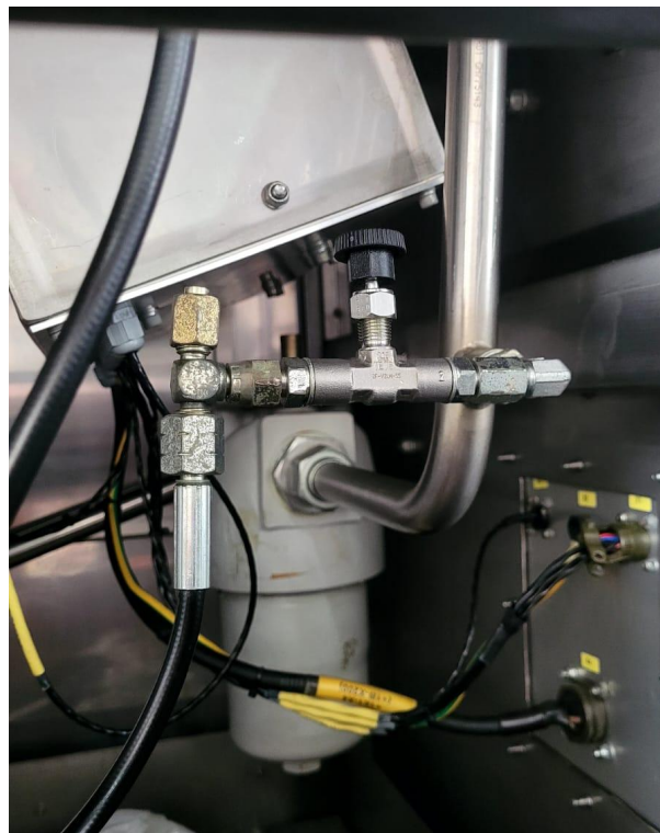
Fotografía 2. Tubería sin filtraciones.
