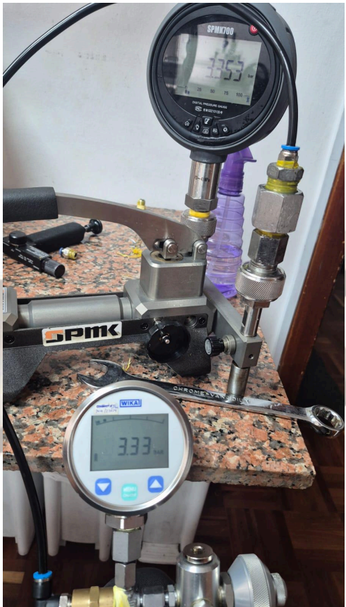
Figura 3: Funcionamiento del equipo post soldadura.
